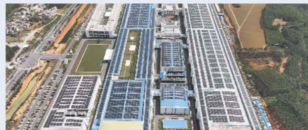
廠區屋面安裝光伏板
