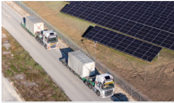
保加利亚·索非亚 50 MWh
