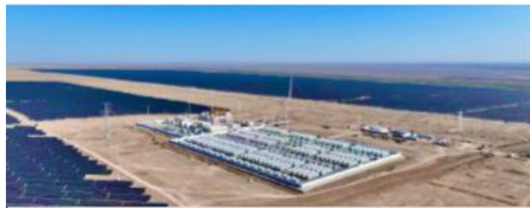
“莎车”项目 800 MWh 新疆 光伏配储
